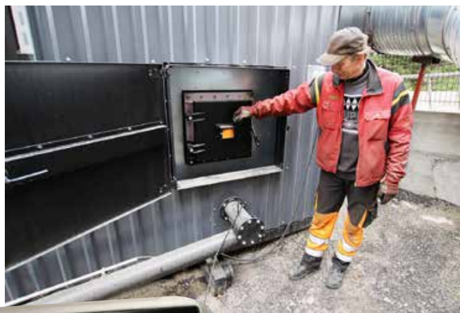
Hydraulisesti nostettava katto mahdollistaa matalan sisäkorkeuden pannuhuoneessakin. Konvektiokanavien nuohous tehdään yläkautta.
